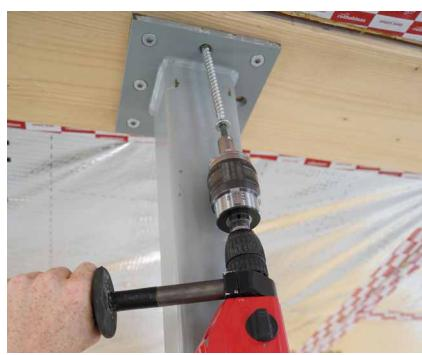
Beim Eindrehen rastet der TORQUE LIMITER beim eingestellten Drehmomentwert aus.
