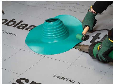
Sellado con aire caliente
