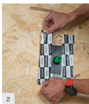
Sellado con aire caliente
