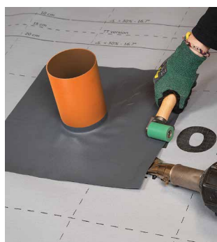
Sellado con aire caliente
