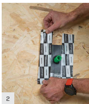
Scellement avec air chaud
