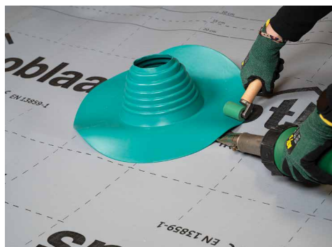
Verschweißen mit Heißluft
