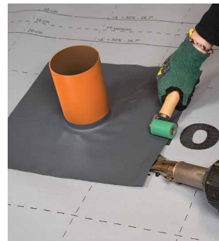
Verschweißen mit Heißluft
