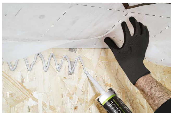
POŁĄCZENIE MEMBRANY Z POKRYCIEM - OSB
