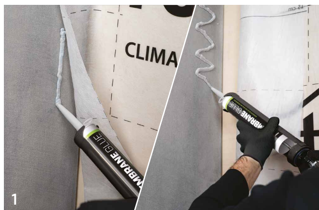
POŁĄCZENIE MEMBRANY NA ŚCIANIE - BETON
